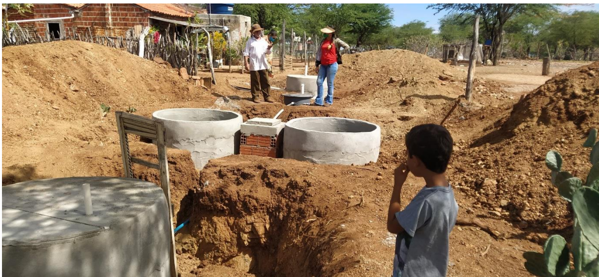
Bild 1: Bau einer Abwasserbehandlungsanlage in der Landgemeinde Esfomeado, Foto: IRPAA
